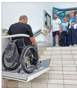
Dieser Treppenlift ermöglicht Rolli-Fahrern wie Karl-Heinz Fröhlich den Zugang zum Hallenbad.
