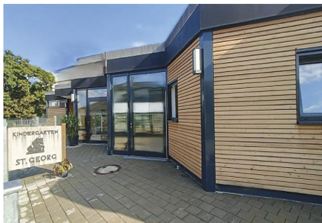
Kindergarten St. Georg
