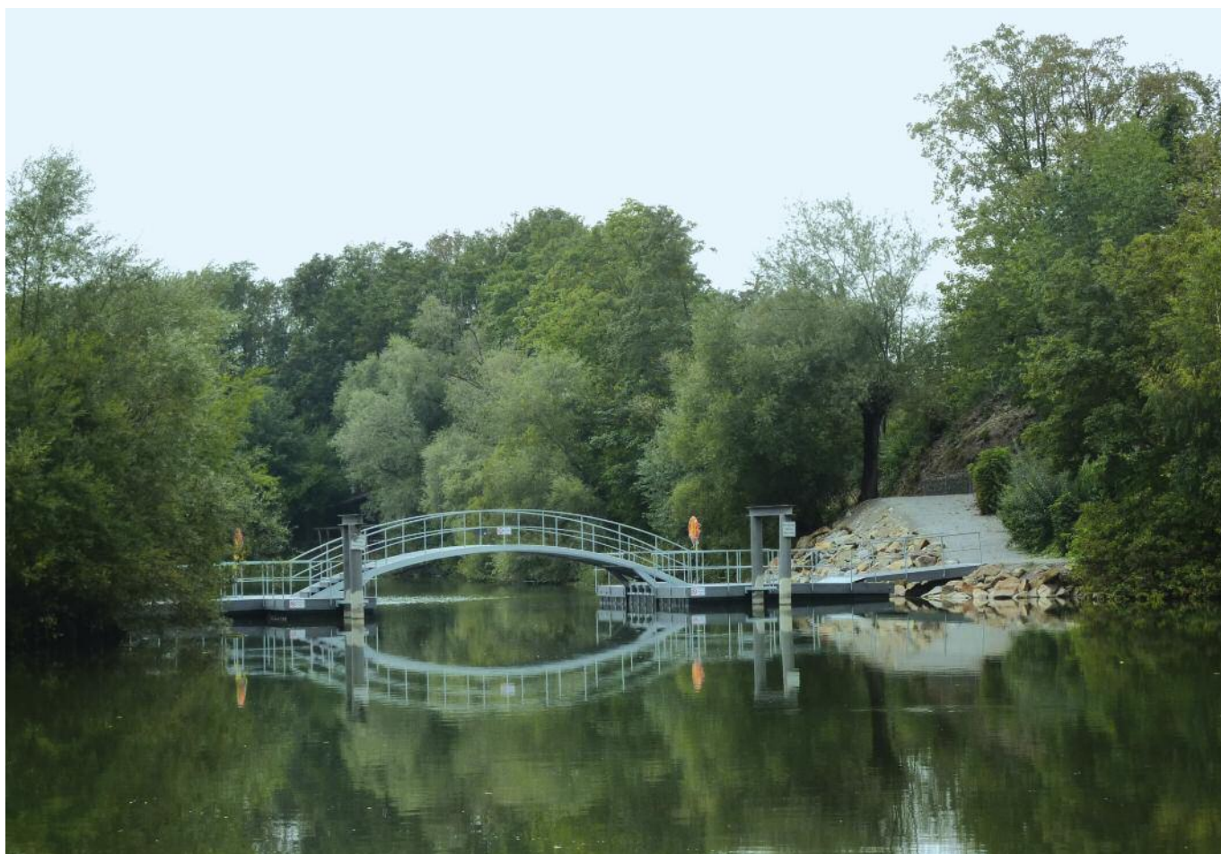
Die nördliche Brücke ist mit einem Durchlass versehen, der das Verlassen des städtischen Naturfreibades auf dem Wasser ermöglicht.
