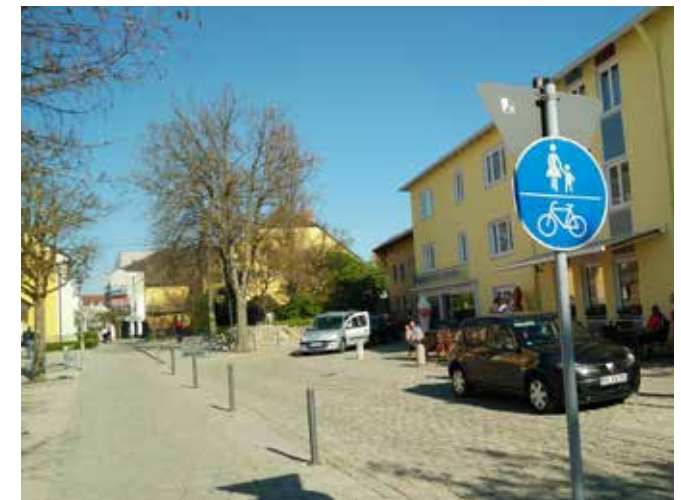
Kirchplatz Südseite Fuß- und Radweg
