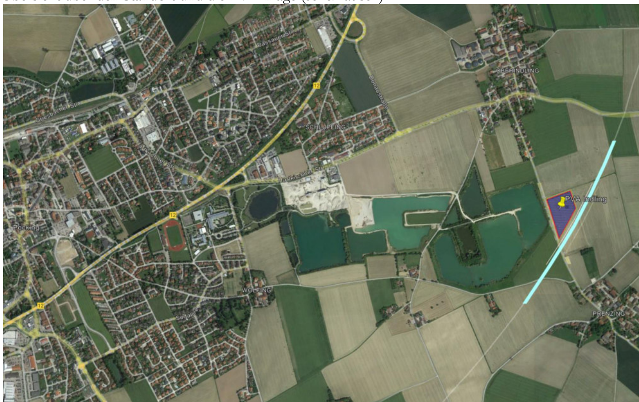
Bild 2.1: Luftbild der PV-Anlage (Quelle: Google Earth / SolPEG)
