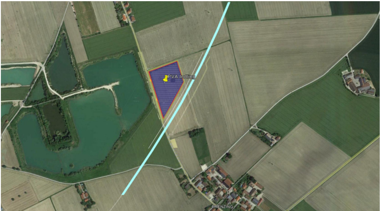
Bild 2.2: Luftbild der PV-Anlage (Quelle: Google Earth / SolPEG)
