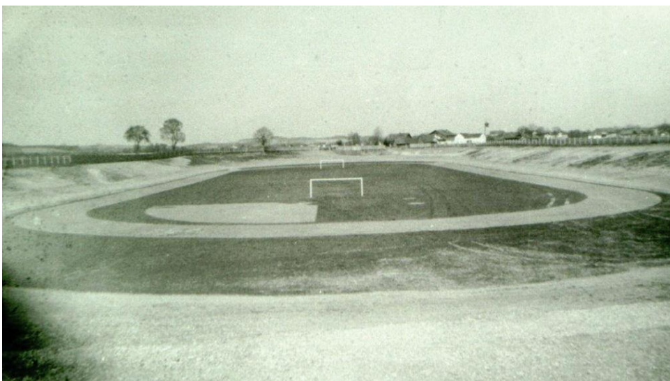
Das „Olympiastadion des Rottals“ nach der Fertigstellung im Jahr 1953.
