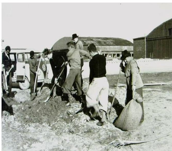
Bau der Start- und Landebahn
