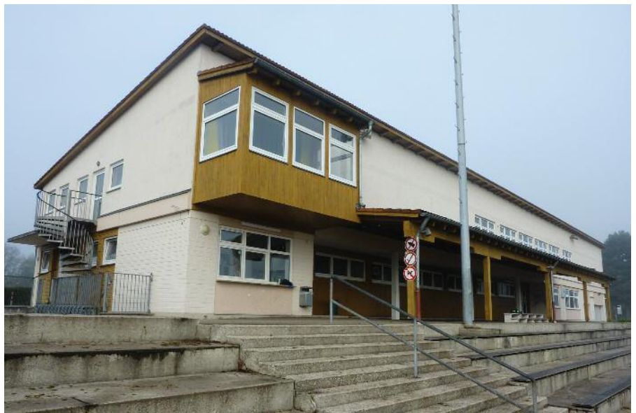
Kein warmes Duschwasser gibt es in der Schulsportanlage von Mitte November bis einschließlich Februar.
