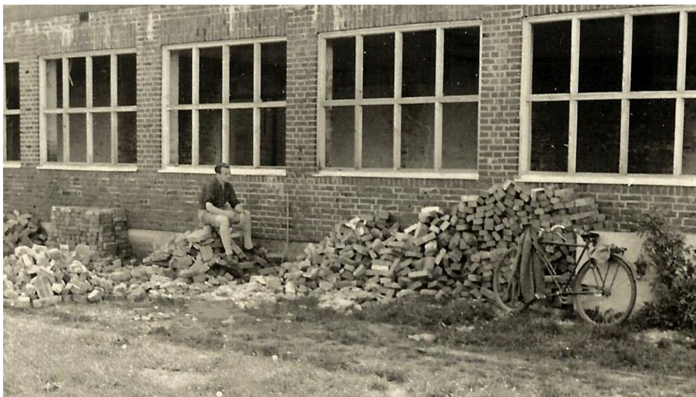
Flugzeughalle vor der Instandsetzung
