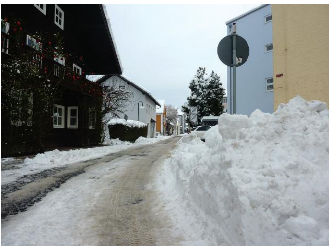
... und an der Bräugasse konnte nur mit Mühe eine Fahrspur freigeräumt werden. Der Schnee türmte sich entlang dieser frei geräumten Fahrbahnen.
