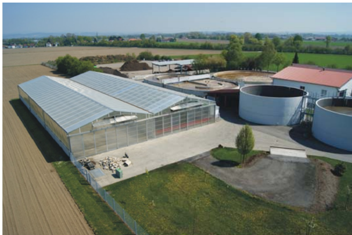
Solare Klärschlamm-trocknung mit "elektrischen Schweinen"
