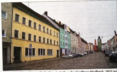
Das gelbe Gebäude vorn beherbergte früher das Gasthaus Haslbeck. 2021 gab es dort die Aktion „Baubüro“.
