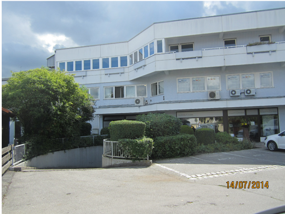
Gebäudebestand Hausnr. 2 - Zufahrt Tiefgarage
