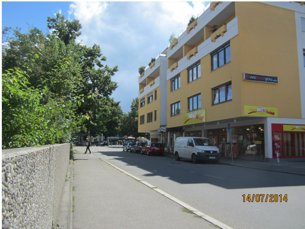
Straßenzufahrt Am Stadtplatz - Einzelhandel-/ Dienstleistungsgebäude
