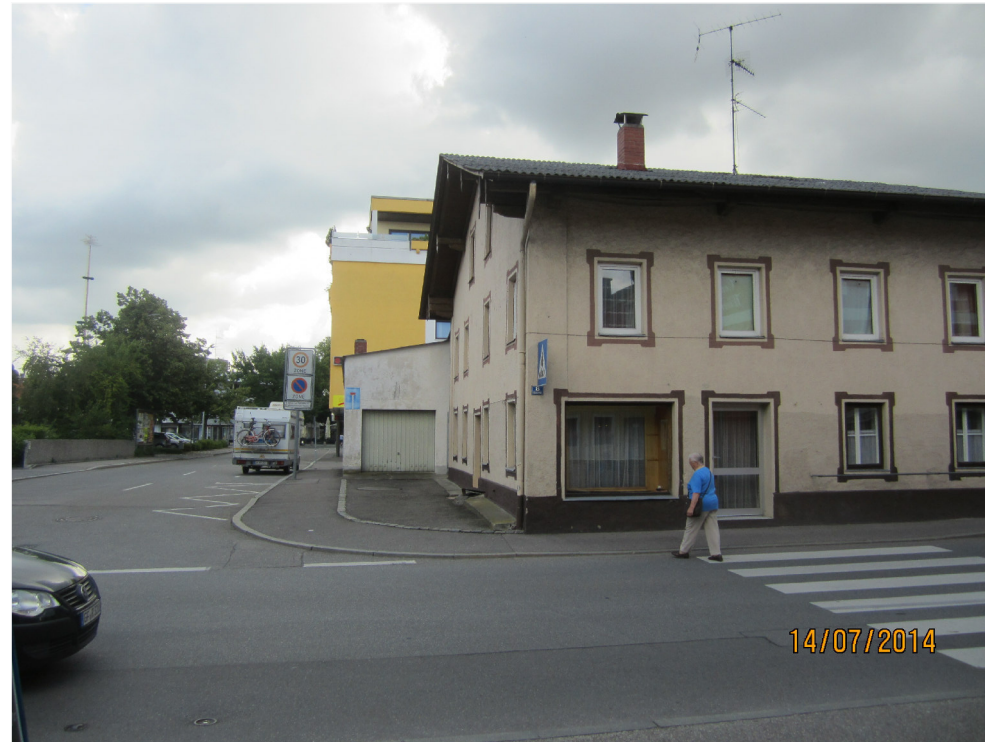
Gebäudebestand Hausnr. 6 - Abbruch
