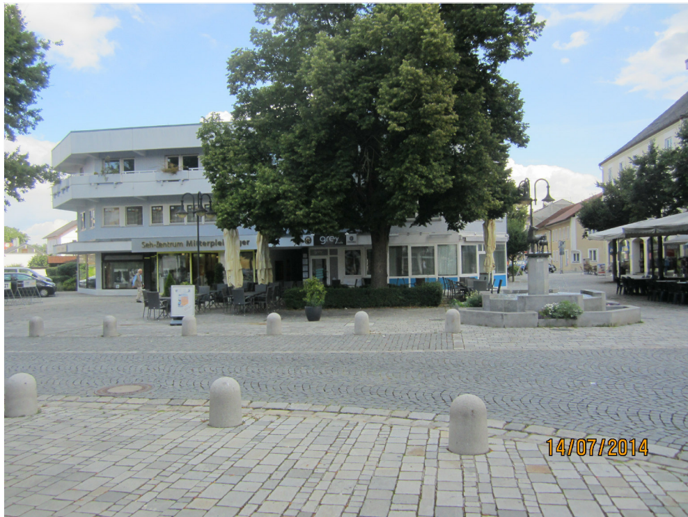
Eckgebäude Zufahrt zum Stadtplatz - Hausnr. 2
