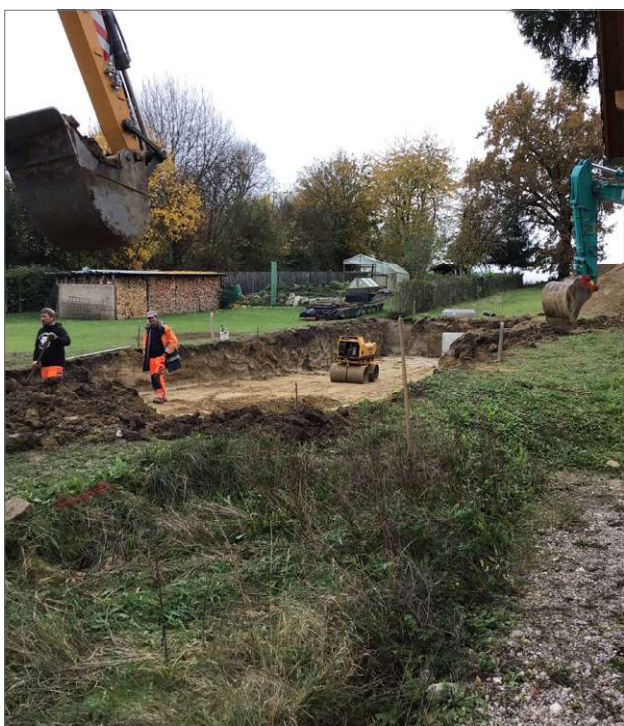
Erschließung durch den Bauhof.
