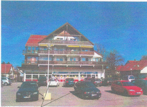
Bild 1: Ansicht von Süden und Teil der zugehörigen Stellplätze
